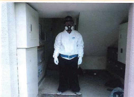
・石綿作業保護具着用（足場工）
