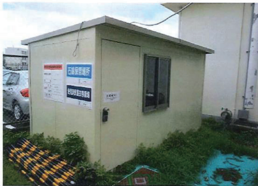
石綿作業員更衣室兼石綿廃棄物一時保管庫
