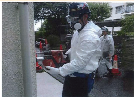
・壁つなぎ穿孔作業状況
