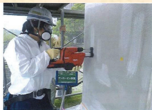
・アンカーピン穿孔作業状況
