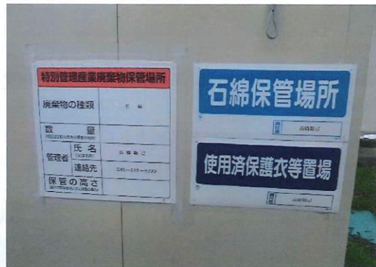
石綿標識板の掲示
